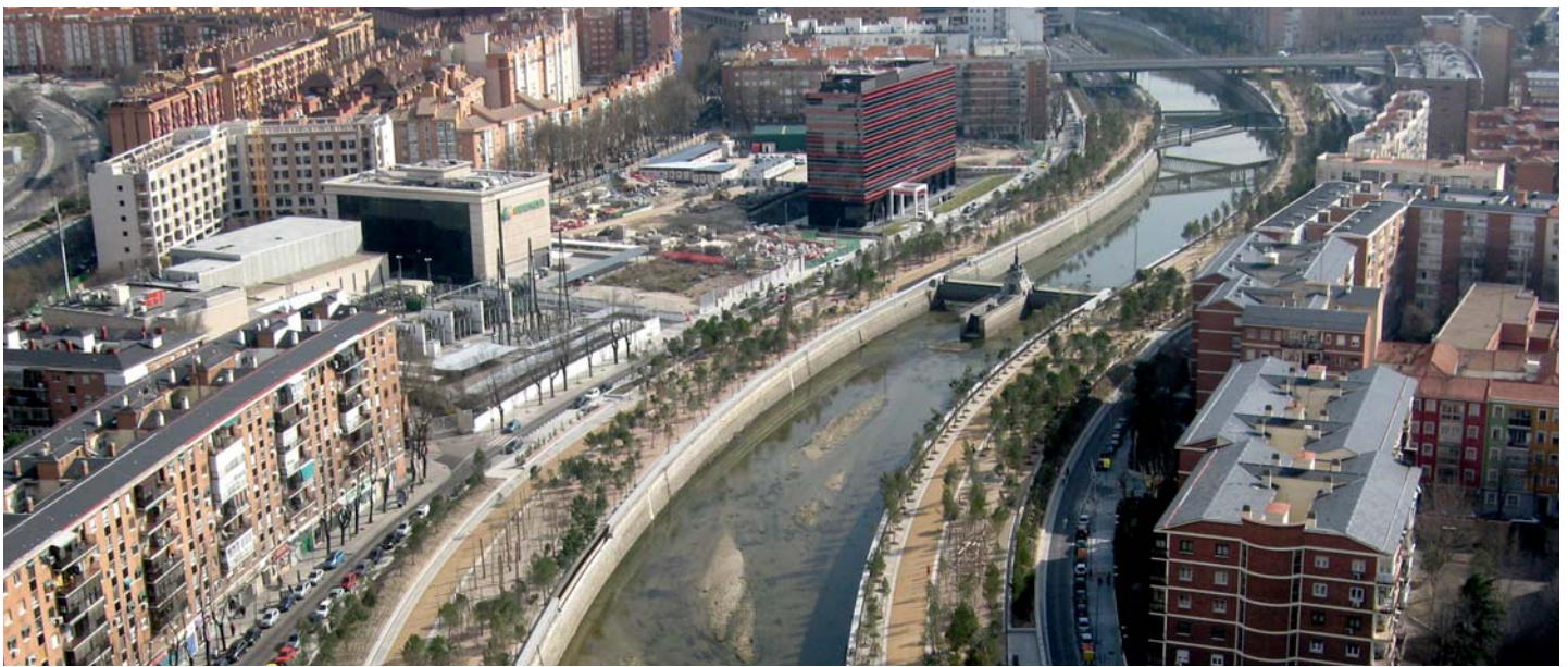
Durch die Verlegung der Autobahn entstand ein 20 bis 25 Meter breiter Grünstreifen am jedem Ufer, der „Salon de Pinos“.
